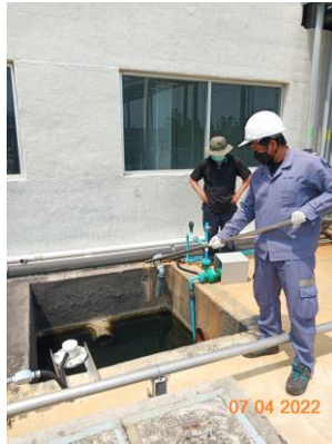
รูปที่ 8 บ่อตรวจสอบคุณภาพน้ำทิ้งของโครงการ (ขนาด 8 ลูกบาศก์เมตร)
