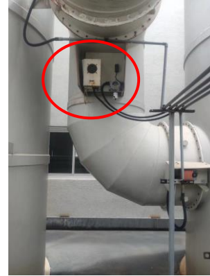
รูปที่ 2 เครื่องตรวจวัดคุณภาพอากาศ (HCl) แบบต่อเนื่อง
